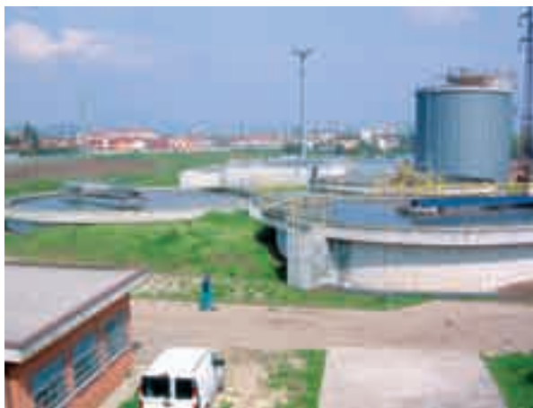
Impianto di depurazione in località Palù di San Bonifacio
