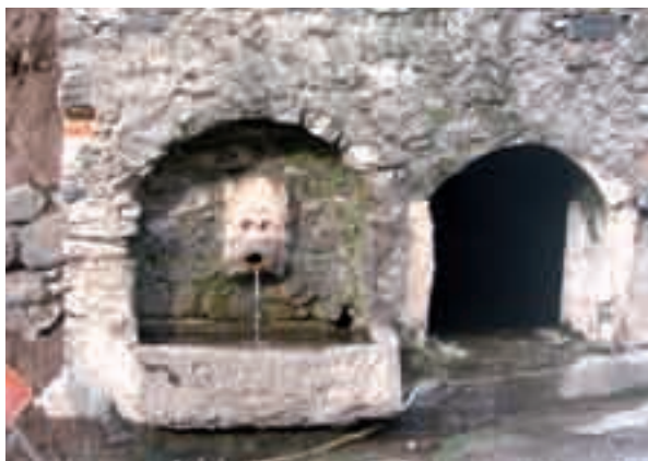
Sopra sorgente a San Giovanni Ilarione. A destra pozzo per acqua a Monteforte d'Alpone
