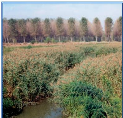
**SISTEMI A FLUSSO SUPERFICIALE:** consistono in vasche o canali dove la superficie dell'acqua è esposta all'atmosfera ed il suolo, costantemente sommerso, costituisce il supporto per le radici delle piante emergenti. Un esempio è rappresentato da alcuni tipi di lagunaggi o "constructed wetlands" inglesi.
